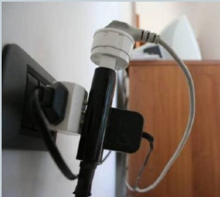
Le correnti nel circuito sono normali, ma l'aumento di resistenza nel punto di connessione può generare surriscaldamenti localizzati. In caso di distacchi temporanei dei contatti, si possono anche verificare **archi elettrici**.
