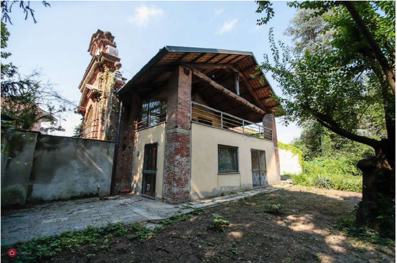
La porta di ingresso: prospetto NORD
