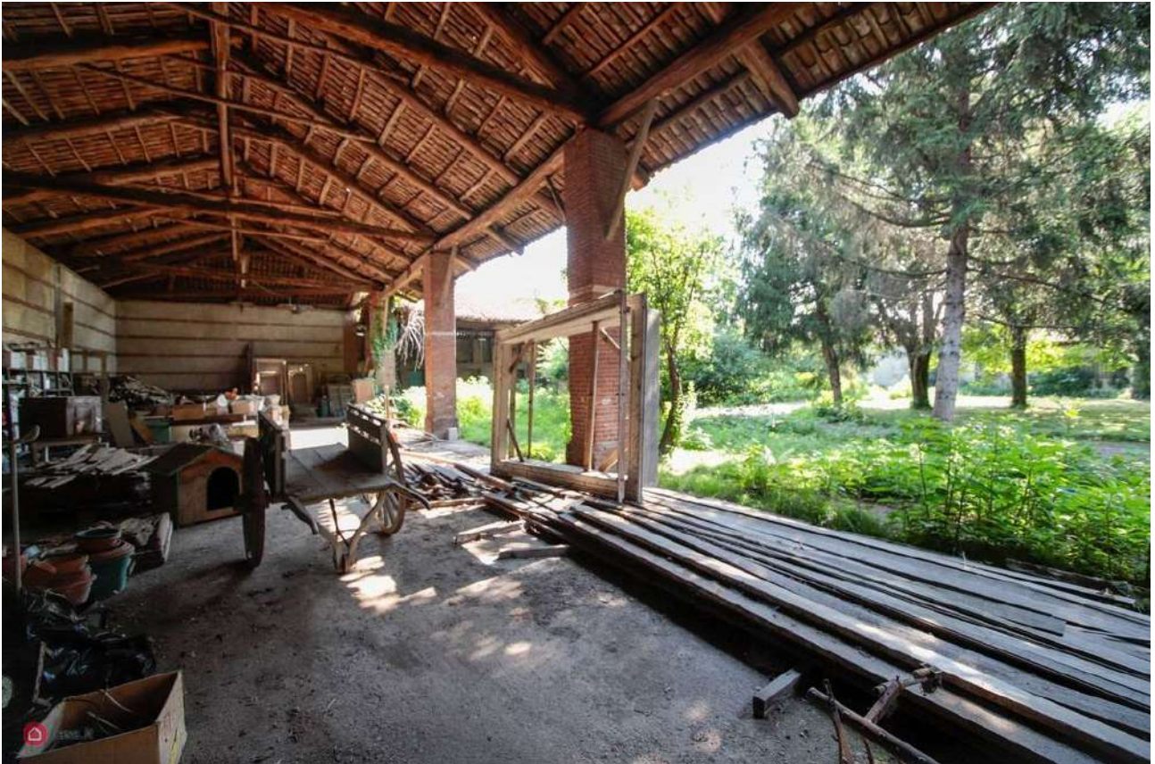
La tettoia: vista verso EST
