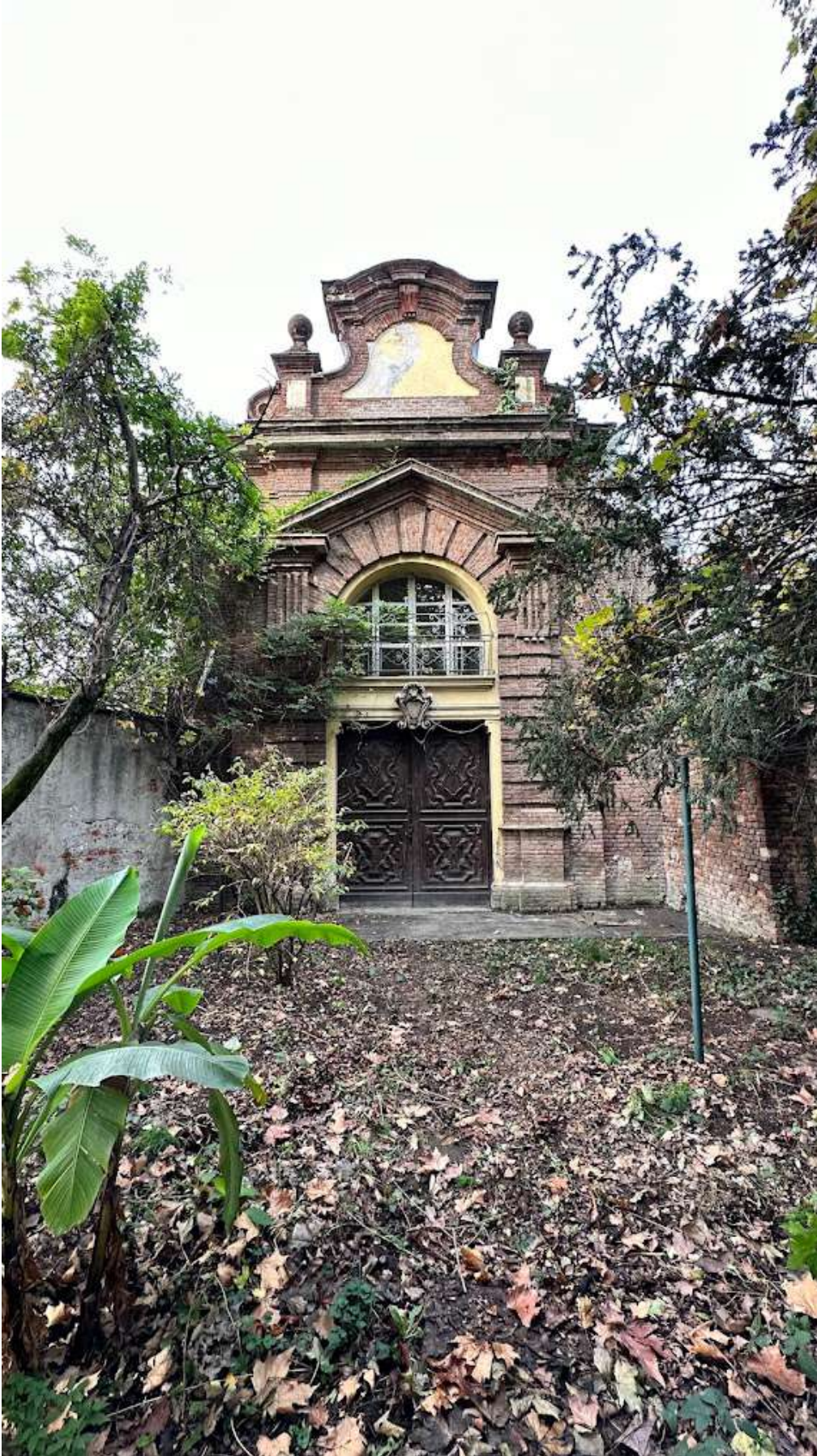
La porta di ingresso: prospetto EST
