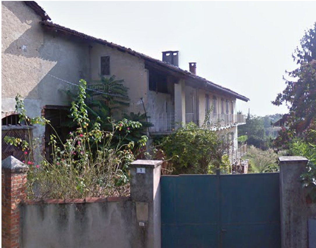
5) FACCIATA LATO STRADA Ingresso lato strada
