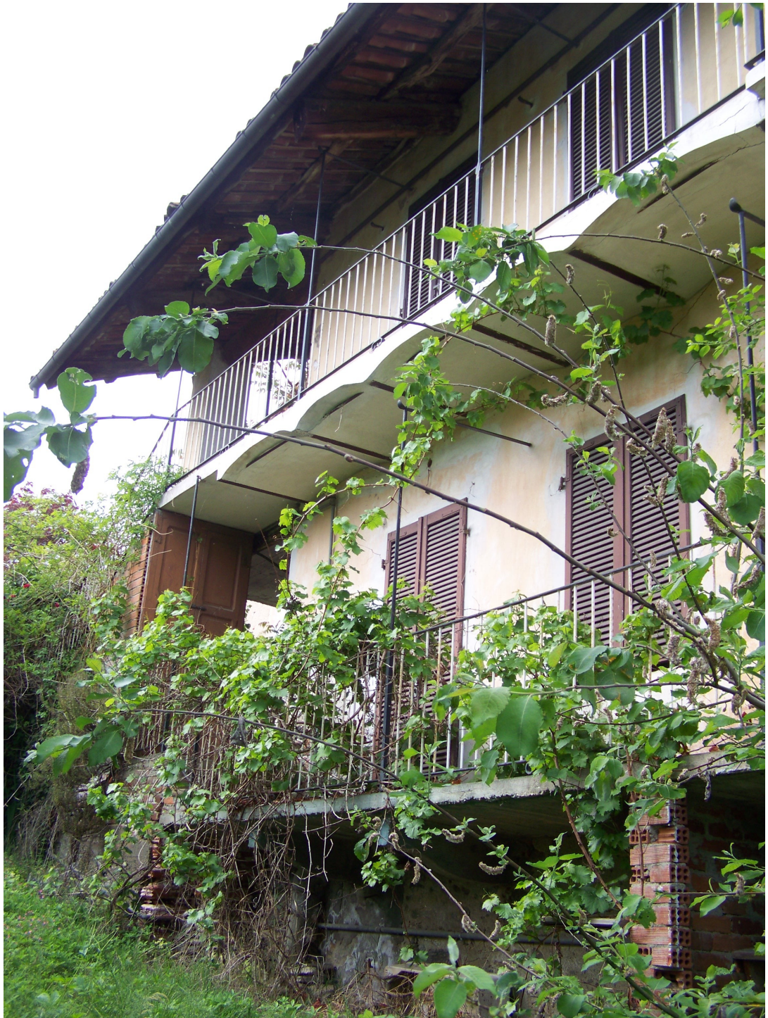
2) FACCIATA LATO SUD
