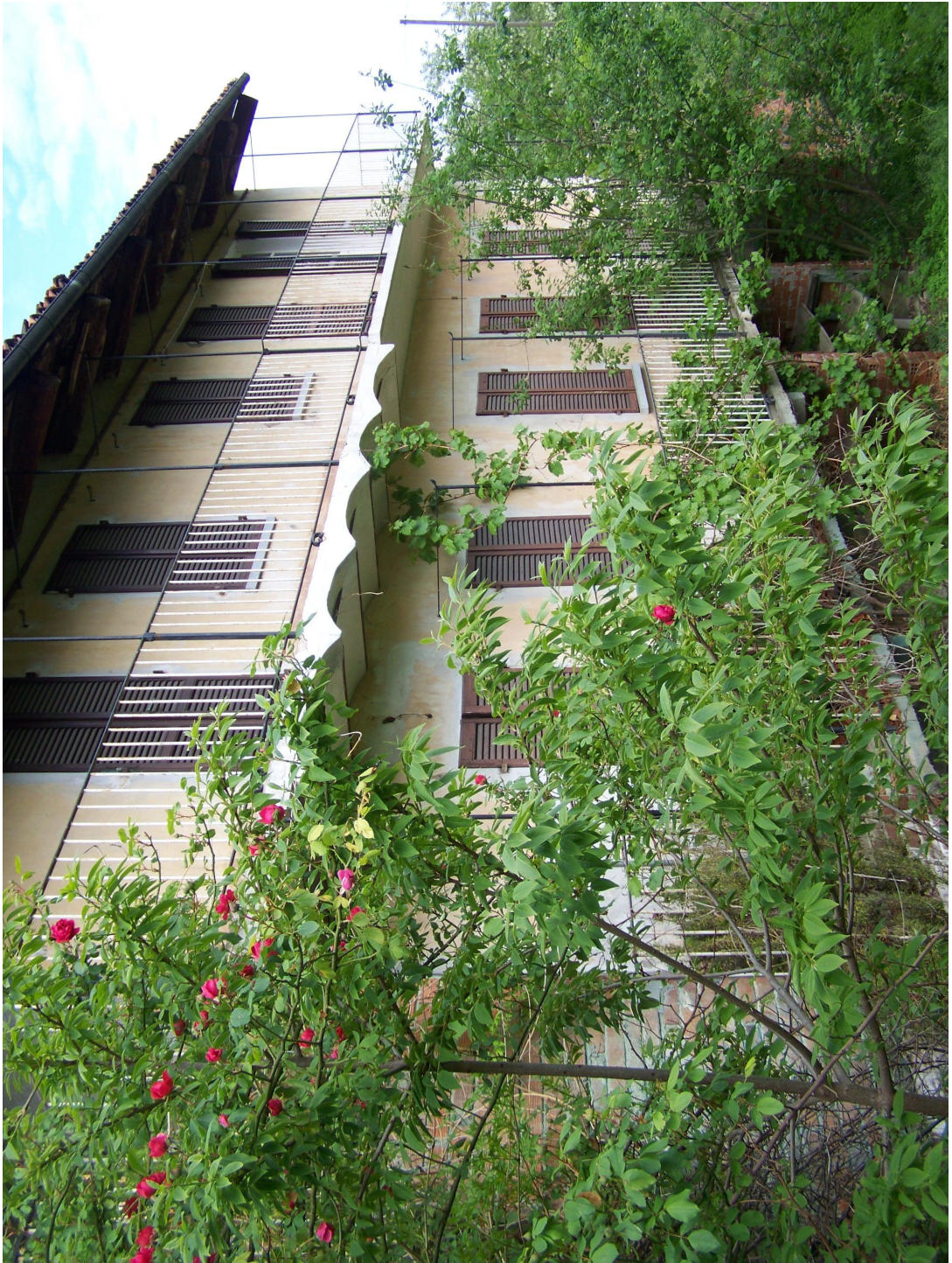
1) FACCIATA LATO SUD
